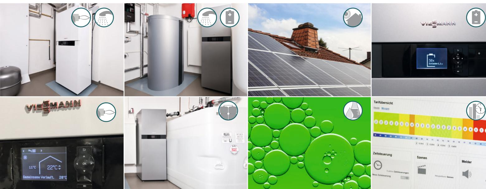
In dem 1992 errichteten Einfamilienhaus werden in einer internetfähigen Hybridheizung mit integriertem Trinkwasser-Ladespeicher eine Luft/Wasser-Wärmepumpe und ein Öl-Brennwertmodul kombiniert. Das Brennwertmodul hat einen Nenn-Wärmeleistungsbereich von 9,6 bis 23,6 kW, die Wärmepumpe hat eine Nenn-Wärmeleistung nach EN14511 bei A2/W35 °C von 2,7 bis 10,9 kW. Das Gerät ersetzt einen fast 25 Jahre alten Niedertemperatur-Ölheizkessel.
